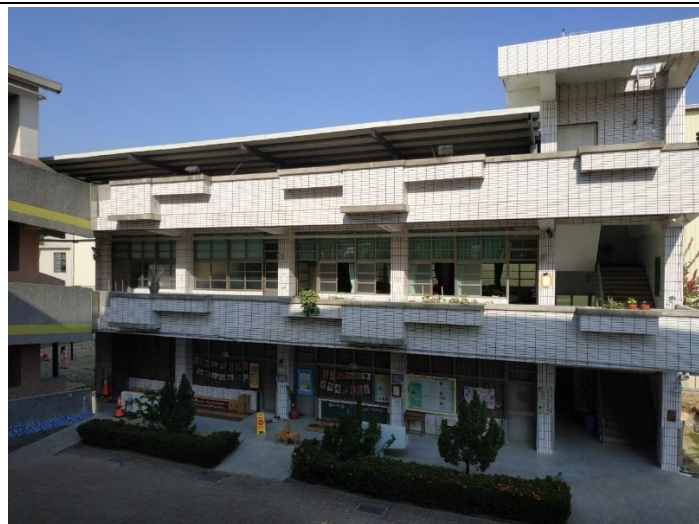
東棟教室上方防水隔熱設計
