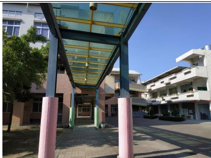
兩棟大樓間連通道遮陽設施
